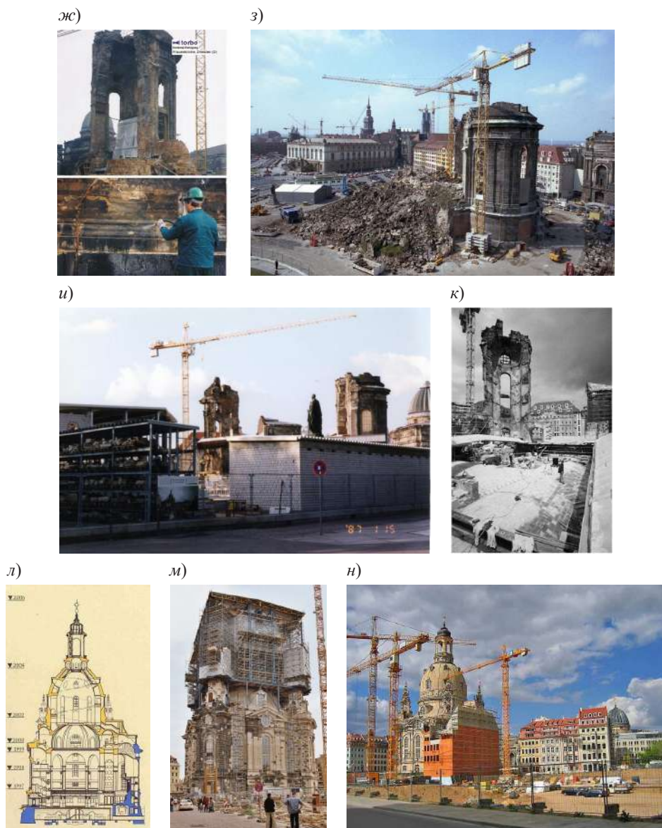
Рис. 150, продолжение. Церковь Богородицы (Фрауэнкирхе) в Дрездене (Германия): ж–к – разбор руин с дефектованием и маркировкой фрагментов церкви Богородицы (Фрауэнкирхе), раскрытие исторических сводов церкви до 1995 г.; л–н – воссоздание церкви Богородицы (Фрауэнкирхе) методом «анастилоз» – фиксация сохранившихся фрагментов в проекте и последующая установка исторических фрагментов на свои исторические места, 1995–2005 гг.
