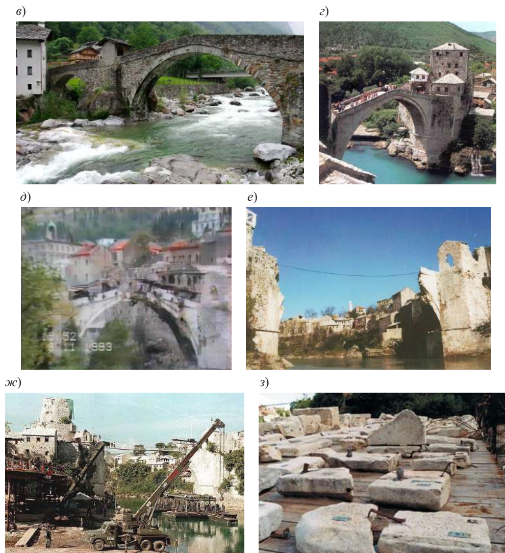
Рис. 144, продолжение . Старый мост в Мостаре (Босния и Герцеговина): в–г – Старый мост до разрушения в 1993 г.; д–е – момент разрушения Старого моста и обрушившиеся конструкции моста, 1993 г.; ж–з – обследование Старого моста и подъем со дна реки фрагментов и конструкций для его воссоздания, 2000-е гг.
