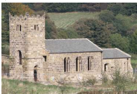
Рис. 128, окончание . Средневековая церковь Святой Елены из Истона (Великобритания): б – воссоздание исторической разрушающейся церкви Святой Елены из Истона путем разборки и перемещения ее в музей под открытым небом Beamish Museum; в – воссозданная церковь Святой Елены в музее под открытым небом Beamish Museum, современность
